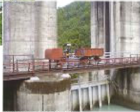
▲ ダム流木抽出1tダンプ台車
