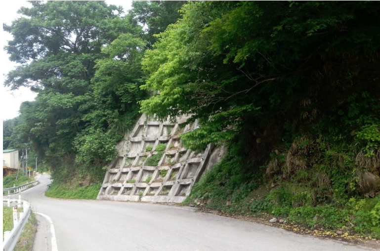
法面全景 のり面の上位斜面、側部斜面も立木、地山ともに安定している。
