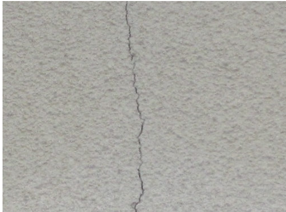
モルタルにはクラックが見られるが拡張性はない
